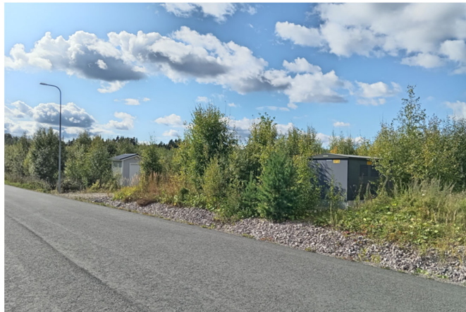
Kuva 34. Suunnittelualueen jätevesipumppaamo ja sähkömuuntamo Rastimaa-kadun varrella (Janakkalan kunta, 2025).
