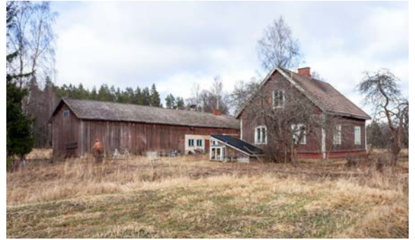
Esimerkki 1900-luvun alkupuoliskon maatilasta, Metsäpirtintie 10, alueen koillisosassa.
