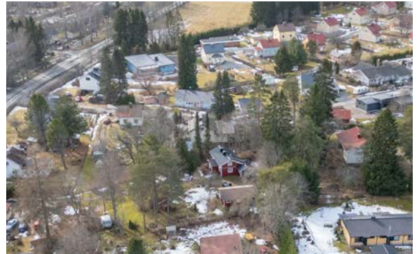
Vinkintien ja Kekanahontien välisellä alueella on muutamia vanhempia asuin- ja piharakennuksia. Kuvan keskivaiheilla sijaitseva punainen kaksipiippuinen rakennus Untonkujan päässä edustaa alueen 1920-1930-luvun rakennuskantaa.
