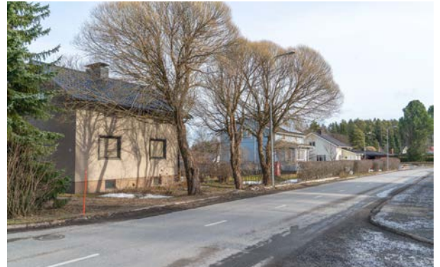
Kekanahontien 1950-lukua, taustalla matalampi aumakattoinen 1970-luvun rakennus.
