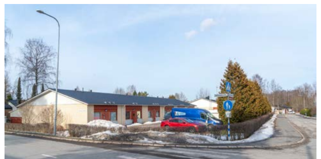
1970-luvulla kohdealueelle rakentuivat ensimmäiset rivitalot. Tätä talotyyppiä edustivat Lastujärventien ja Kekanahontien kulmassa sijaitsevat kaksi rivitaloa. Rakennusten katto on muutettu tasakatosta harjakatoksi 2000-luvun alussa. Kohteeseen on takapihalle myöhemmin rakennettu myös katetut verannat.
