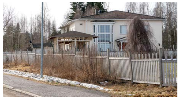
Ylikyläntie 3 on alueelle hieman epätyypillinen, sillä se on kaksikerroksinen, suuren mittakaavan omakotitalorakennus. Julkisivussa on hyödynnetty kertaustyylinomaisesti pylväsaiheita. Kahitiilisenä ja aumakattoisena rakennuksena se toistaa ajan rakentamisessa ja Moisio-Kyterin alueella 1980-1990-luvuilla yleistyneitä teemoja.
