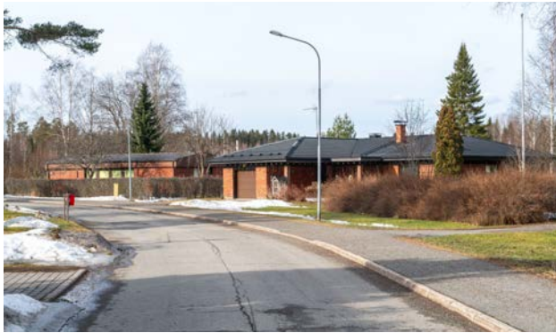
Moisio-tyyppitalojen jatkona Kyterintiellä alkaa 1970-1980-lukuisten omakotitalojen sarja. Kuvassa oleva 1975 valmistunut pientalo edustaa tyyllisesti hyvin näitä usein aumakattoisia puurakenteisia tiiliverhoiltuja omakotitaloja.
