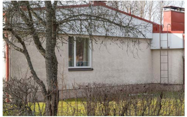
Moisio -tyyppitalojen julkisivuissa vuorottelevat rappaus, tiili, puu ja rakennuslevyt.
