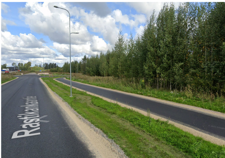
Kuva 20. Rastikankaantie ja sen viereinen kevyen liikenteen väylä (Google, 2025).
