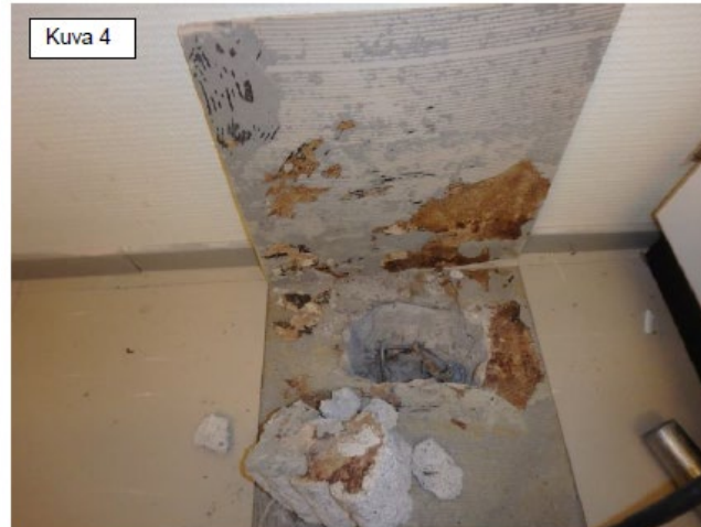
Vinyylilaattojen alle on jätetty musta liima.
