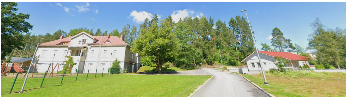
Kuva 18. Suunnittelualueen lähistön rakennuskantaa; entinen sairaalarakennus (Vapari) ja päiväkotipesäpuu.
