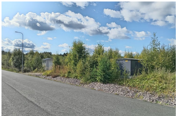
Kuva 22. Suunnittelualueen jätevesipumppaamo ja sähkömuuntamo Rastimaa-kadun varrella (Janakkalan kunta, 2025).
