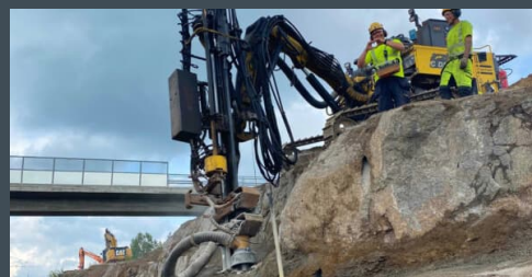
Louhinta ja kalliorakennus
