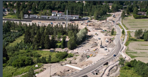
Tie- ja katurakentaminen
