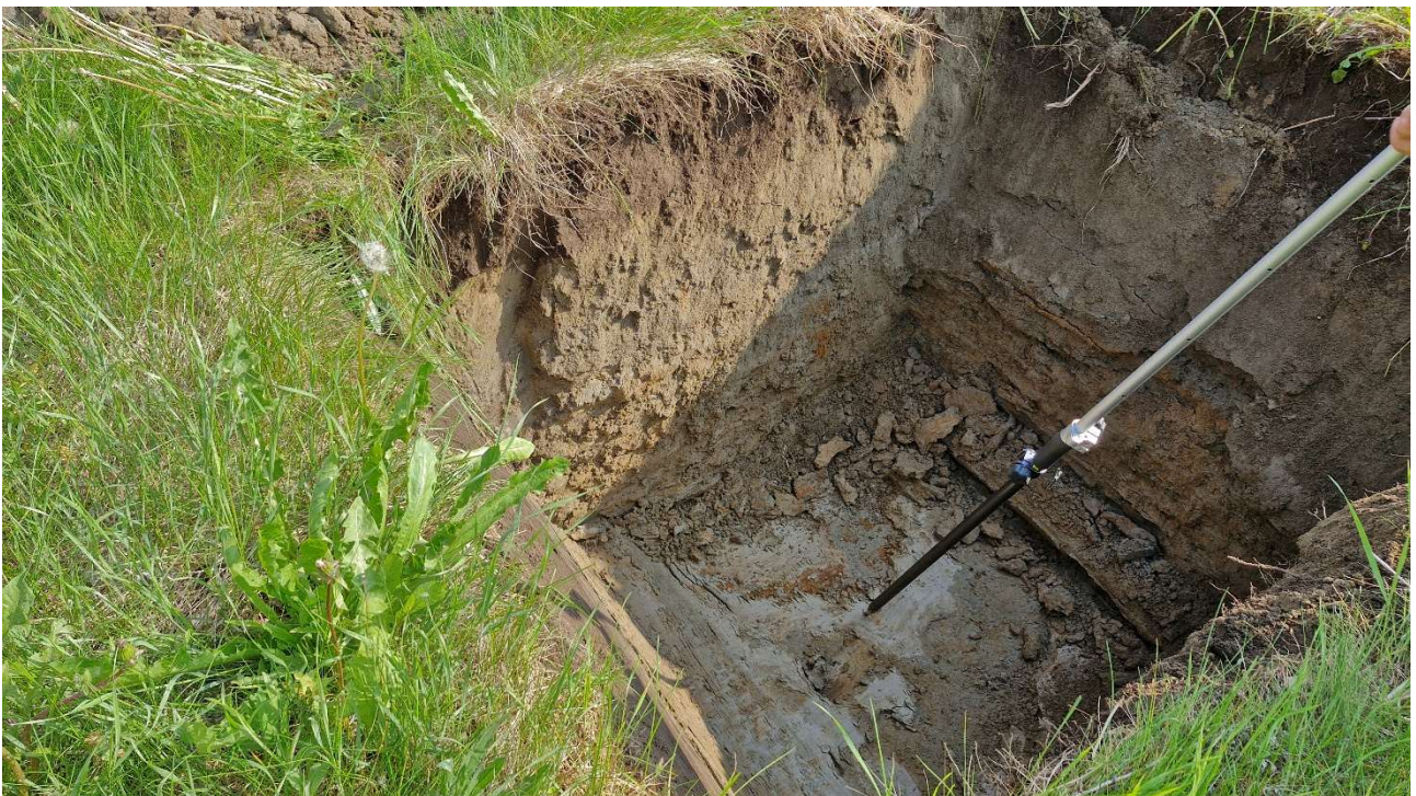
Kuva 14. Koekuoppa 6 kaivuuta. Maanpinta +81,99 m, pohja +80,510 m. Maaperä multa, hiekka/hieta, siltti. Ei havaittu jätettä.
