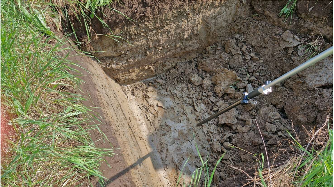
Kuva 15. Koekuoppa 7 kaivuuta. Maanpinta +81,89 m, pohja +80,645 m. Maaperä multa, hiekka/hieta, siltti. Ei havaittu jätettä.
