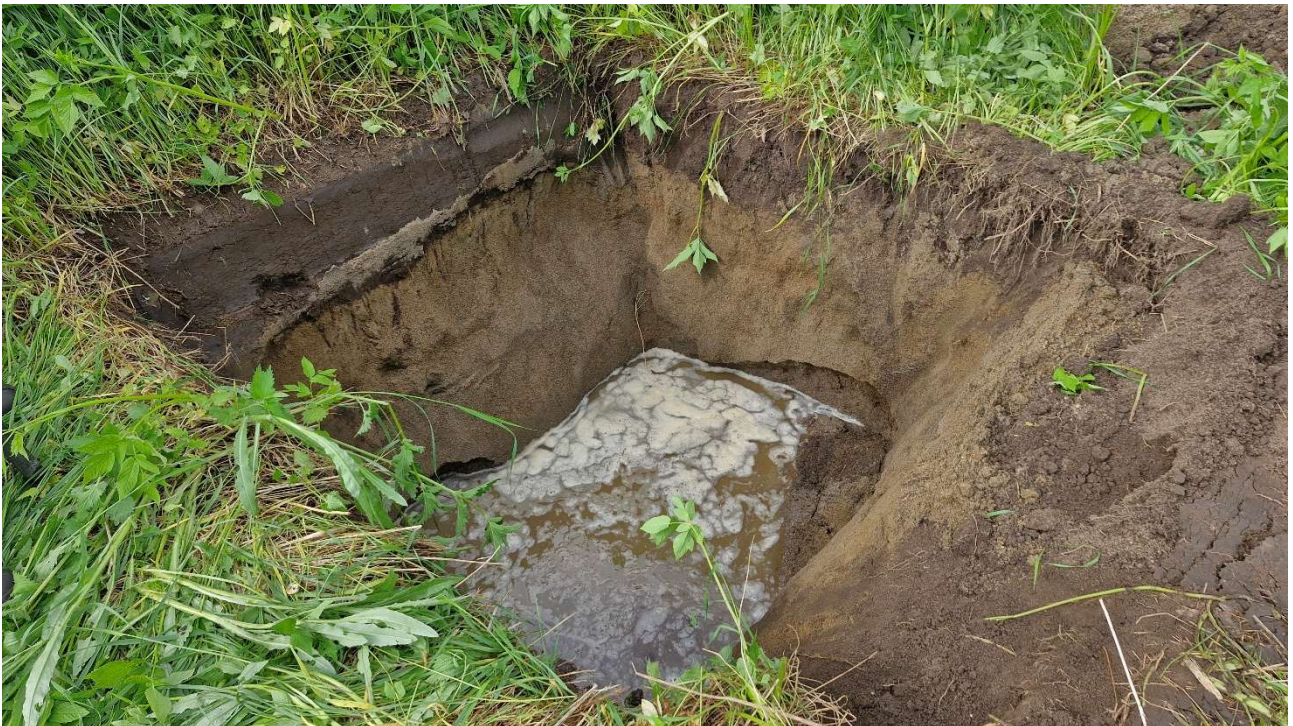
Kuva 16. Koekuoppa 8 kaivuuta. Maanpinta +81,42 m, pohja +79,772 m, vesipinta +80,20 m. Maaperä multa, hiekka/hieta. Ei havaittu jätettä.
