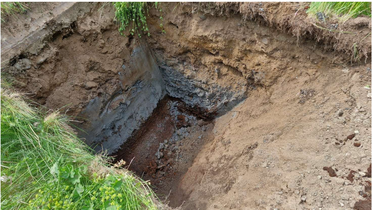
Kuva 26. Koekuoppa 15 kaivuuta. Maanpinta +81,38 m, pohja +79,259 m. Maaperä humusmaa, hiekkamoreeni, savi, turve. Havaittiin turpeen seassa puumaista orgaanista ainesta. Vettä tihkuu pohjan tasolla.
