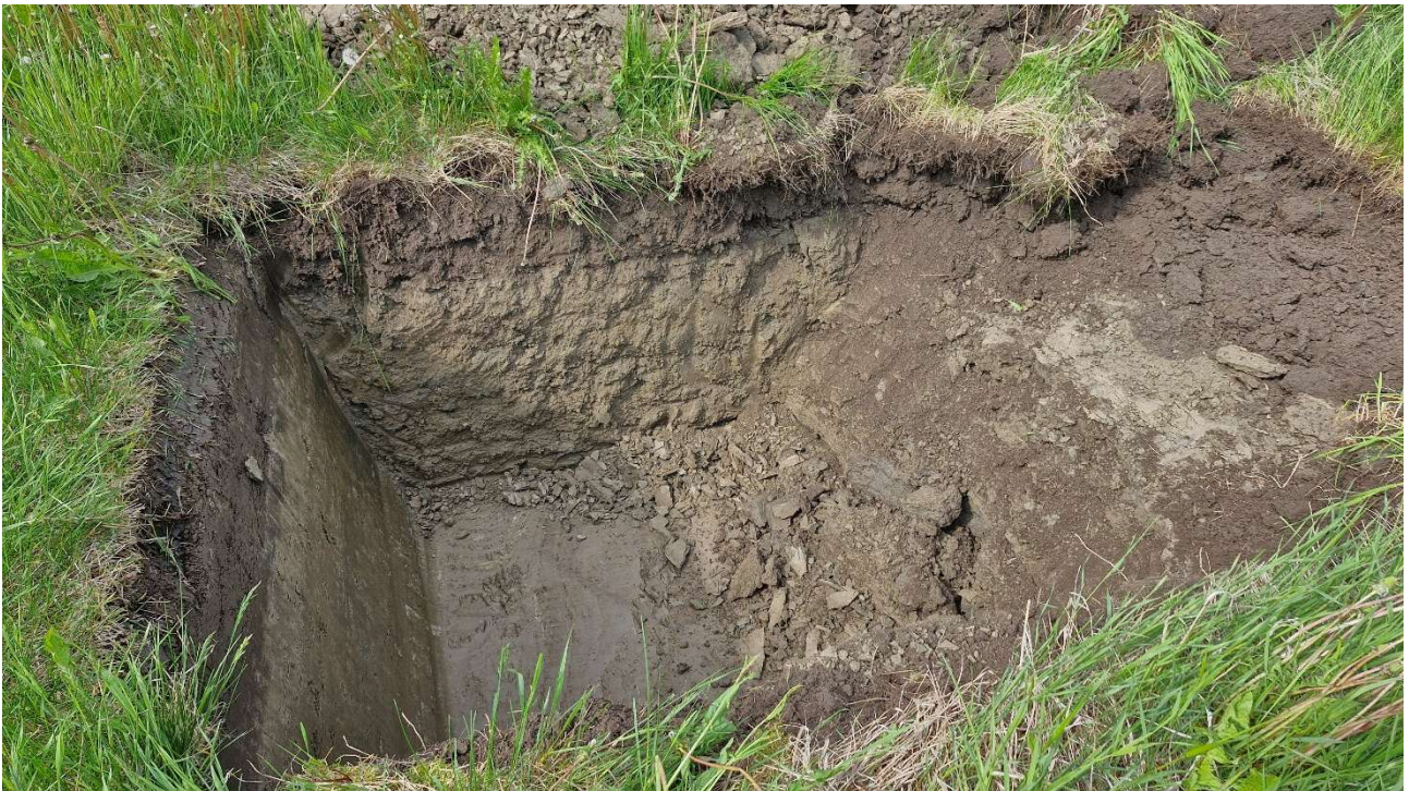
Kuva 18. Koekuoppa 10 kaivuuta. Maanpinta +82,15 m, pohja +80,932 m. Maaperä multa, hiekka/hieta, siltti. Ei havaittu jätettä.
