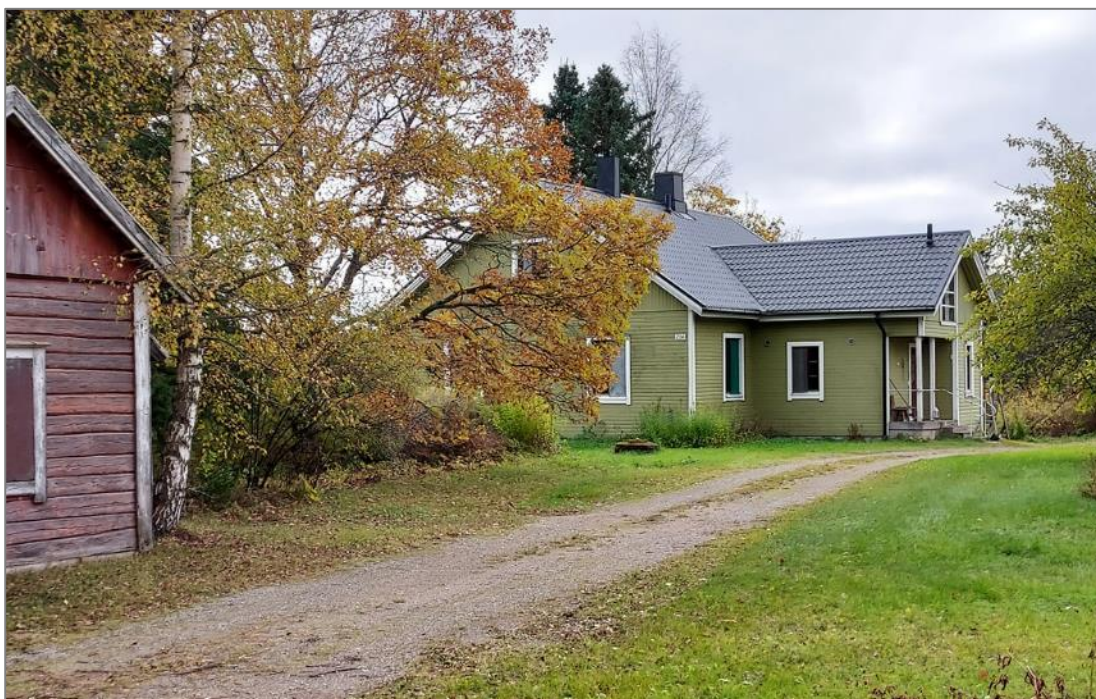
Kuva 117. Ristitien asuinrakennus kuvattuna pohjoisen suunnalta.
