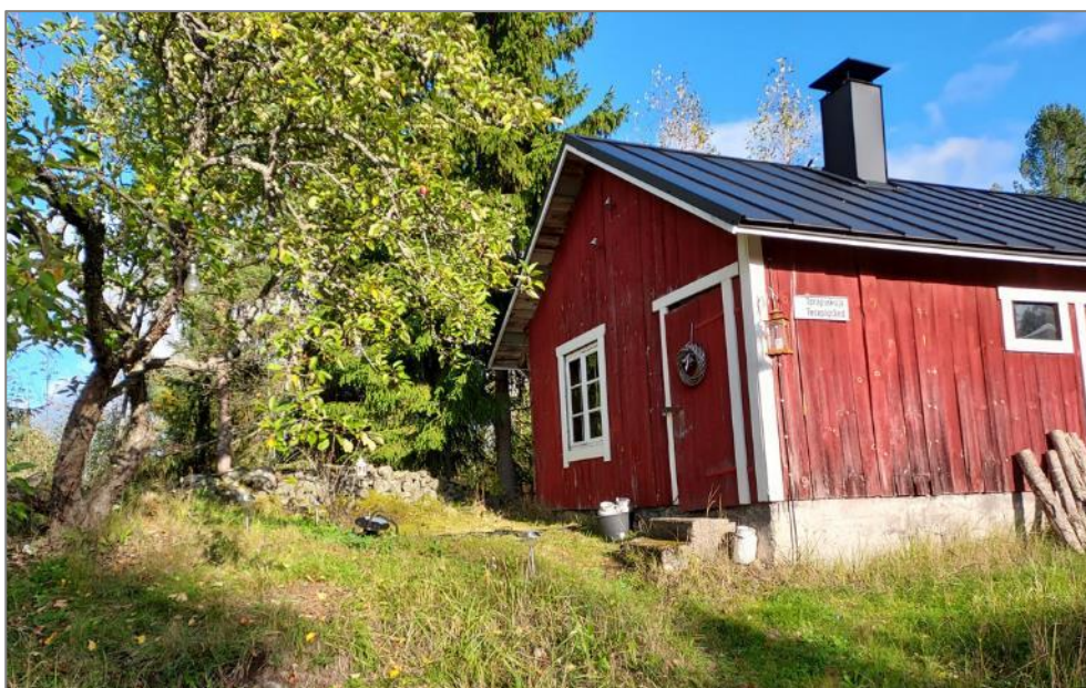
Kuva 78. Pihapiirissä on suhteellisen alkuperäisessä asussa säilyneitä piharakennuksia, kuvassa sauna. Rakennuksen vasemmalla puolella näkyy pihaa rajaava luonnonkivimuuri.
