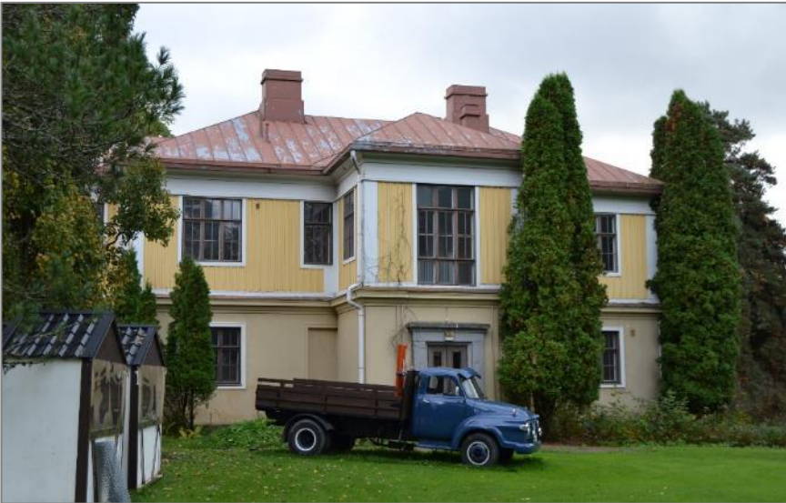
Kuva 34. Konttorirakennuksen luoteispuolen pääjulkisivu.
