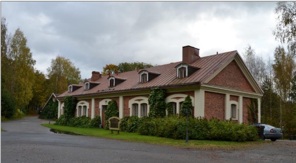
Kuva 38. Entinen autotallirakennus kuvattuna läntiseltä kulmalta.
