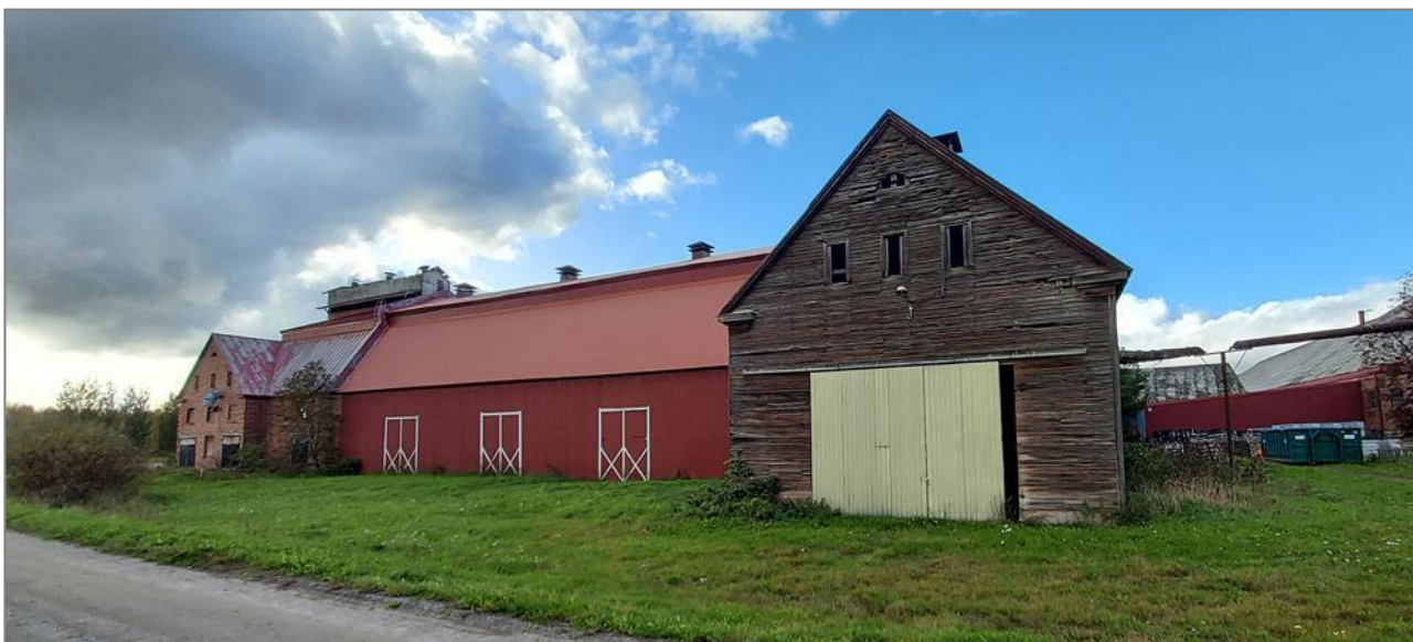
Kuva 56. Hallirakennus kuvattuna koilliskulmalta Katajamäentieltä.
