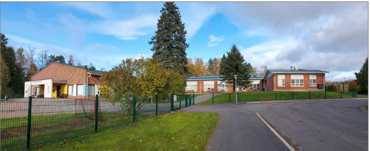
Kuva 111. Kuva Harvialan koulun lounaissivulta. Vasemmalla 2000-luvun päiväkotisiipi, oikealla 1990-luvun ala-asteen laajennus.
