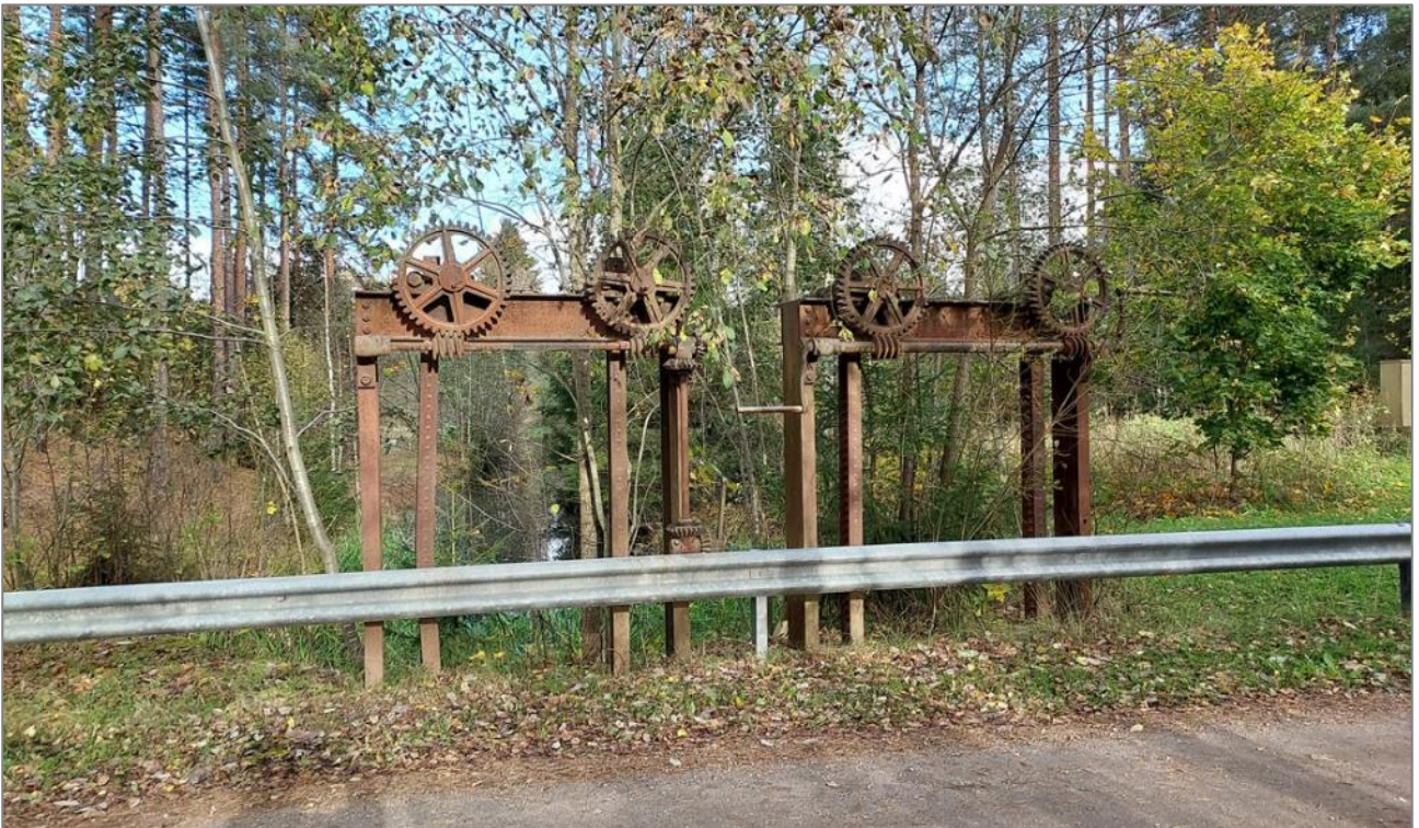
Kuva 91. Rakennuskohde B, Myllynkulmantien varressa säilyneet patolaitteet.
