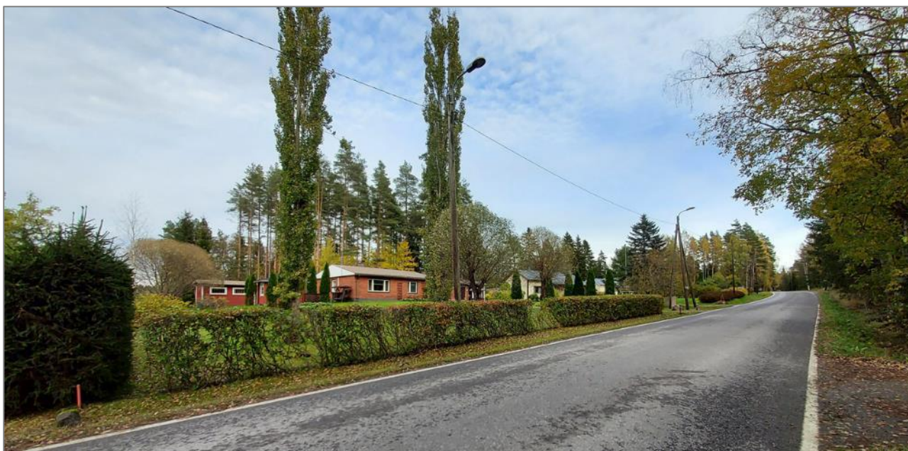
Kuva 28. Heinäjoentien pohjoispuolella sijaitseva, 1960–1970-luvuilla muodostunut omakotitalojen rivi pihoineen muodostaa haja-asutusalueeksi tiiviin kokonaisuuden. Kuvaussuunta on itään.
