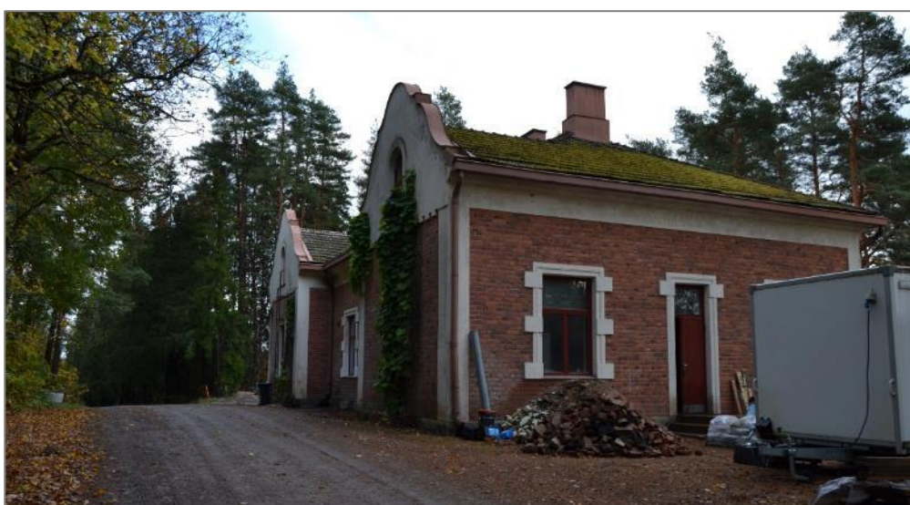
Kuva 44. Rakennus kuvattuna lännestä.
