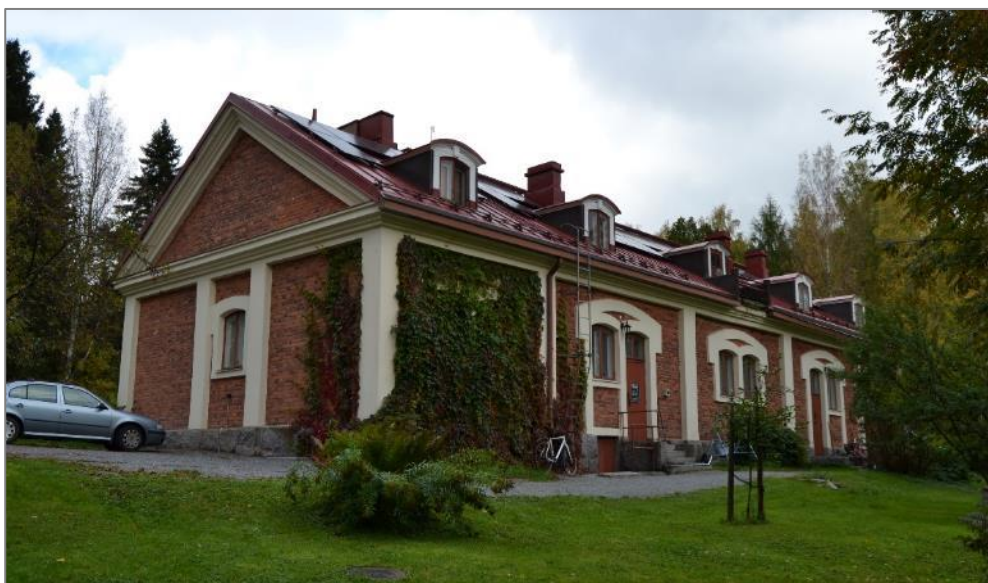
Kuva 39. Rakennuksen kaakkoissivu kuvattuna pihan puolelta.
