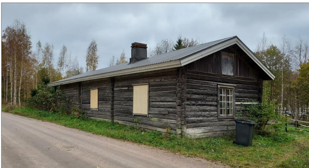
Kuva 113. Rakennuksen luoteispääty ja koillisivu kuvattuna Myllytieltä.
