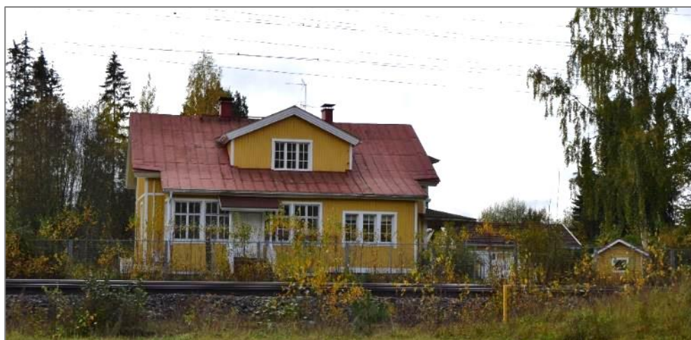
Kuva 46. Entinen asemarakennus kuvattuna radan yli.
