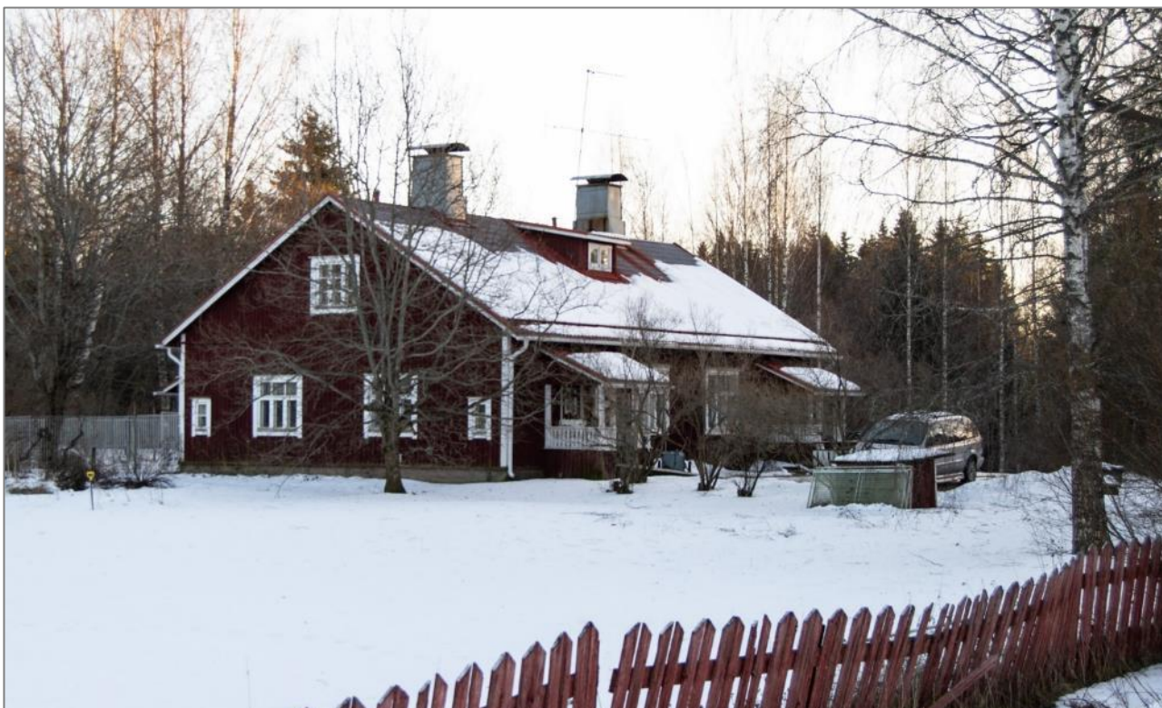
Kuva 64. Nyrkkiälän asuinrakennus kuvattuna rautatien suunnalta.
