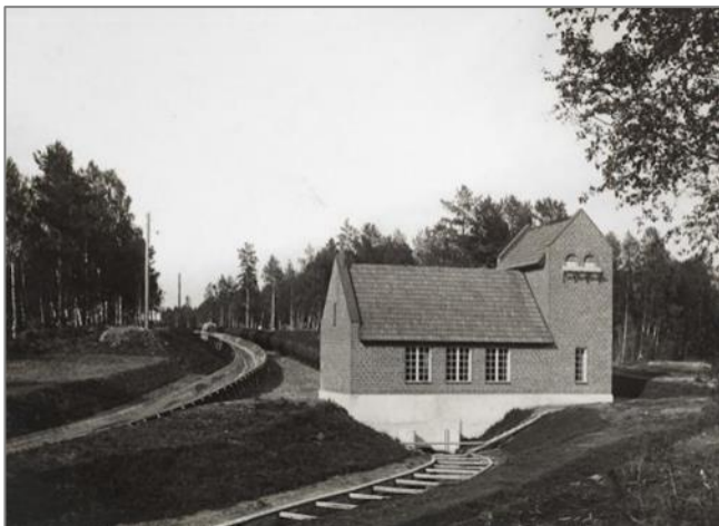
Kuva 101. Harvialan voimala 1910–1920-luvulla. Vasemmalla näkyy uittoruuhi. Kuva: Lusto - Suomen Metsämuseo, Rosenlewin kokoelma.
