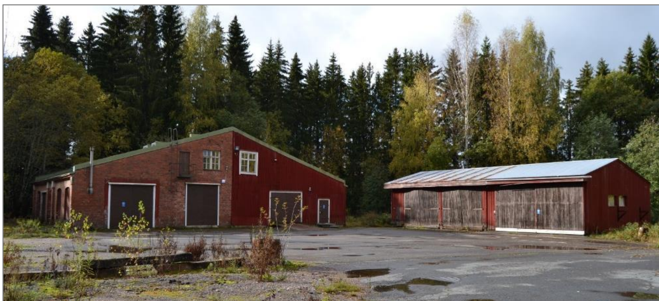
Kuva 68. Entinen korjauspaja (vasemmalla) ja halli kuvattuna koillisesta.
