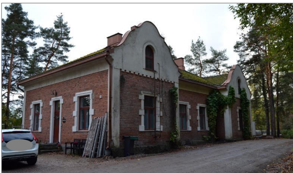
Kuva 43. Saunarakennus kuvattuna koillisesta.
