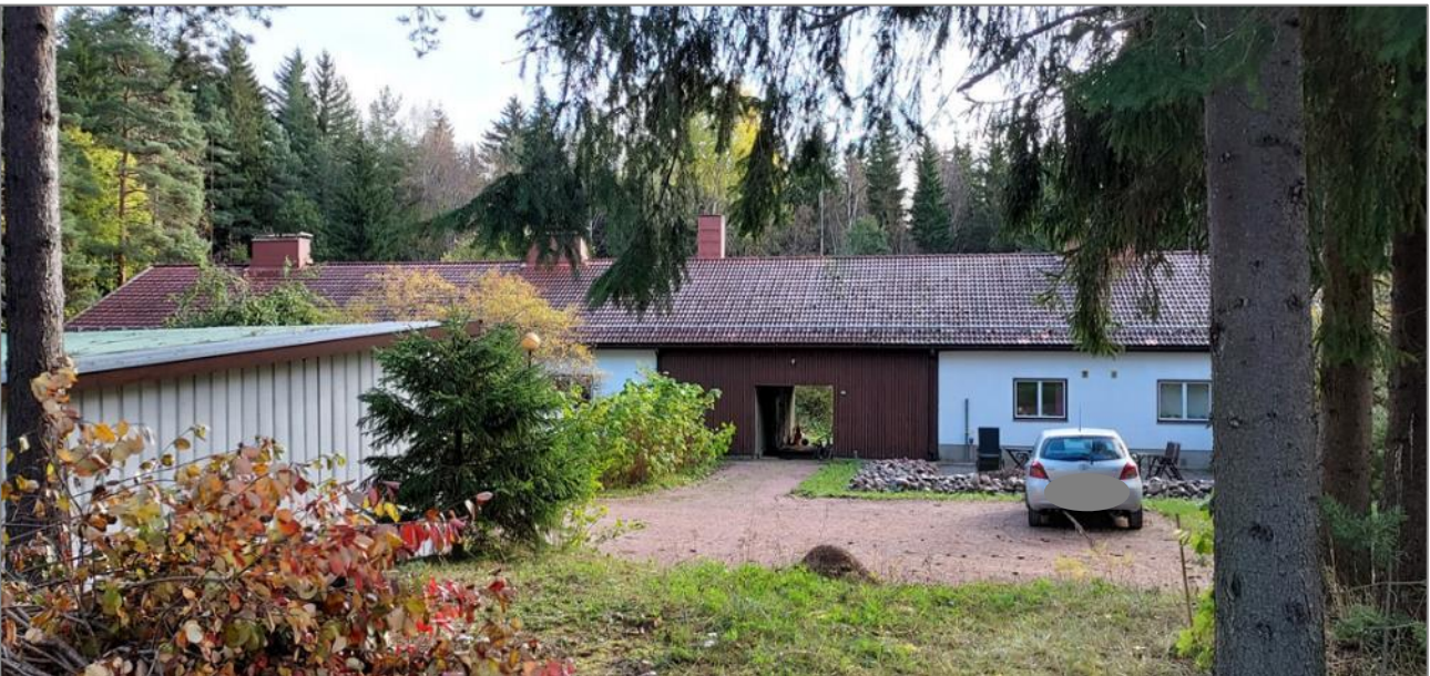
Kuva 70. Hakaportin rivitalo (rakennus C) kuvattuna Myllynkulmantieltä.
