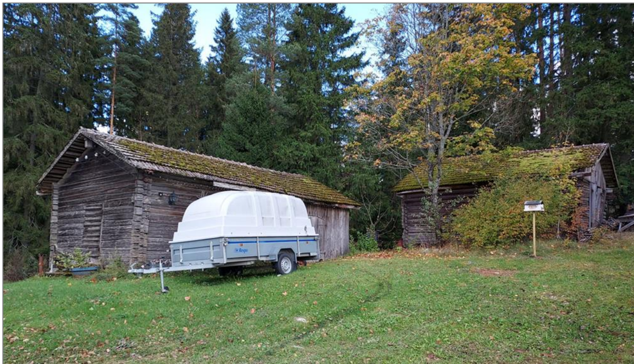
Kuva 75. Aittarakennukset ovat säilyttäneet autenttisen asunsa.
