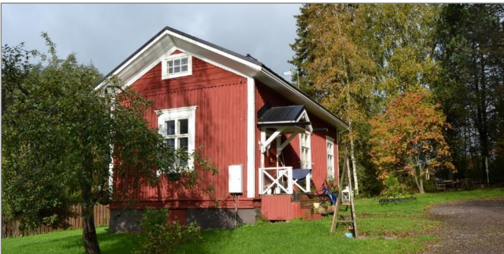
Kuva 48. Vahtituvan eteläpääty ja itäisivua pihan puolelta.
