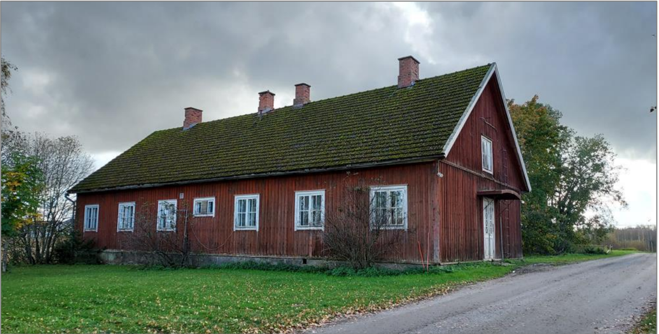
Kuva 53. Rakennuksen koillissivu ja luoteispäätty.
