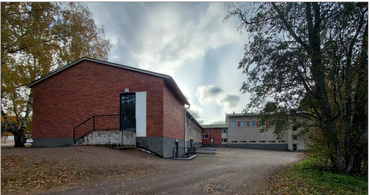
Kuva 109. Kuva koulun pohjoispuolelta. Kuvassa 1960 käyttöön vihitty osa.
