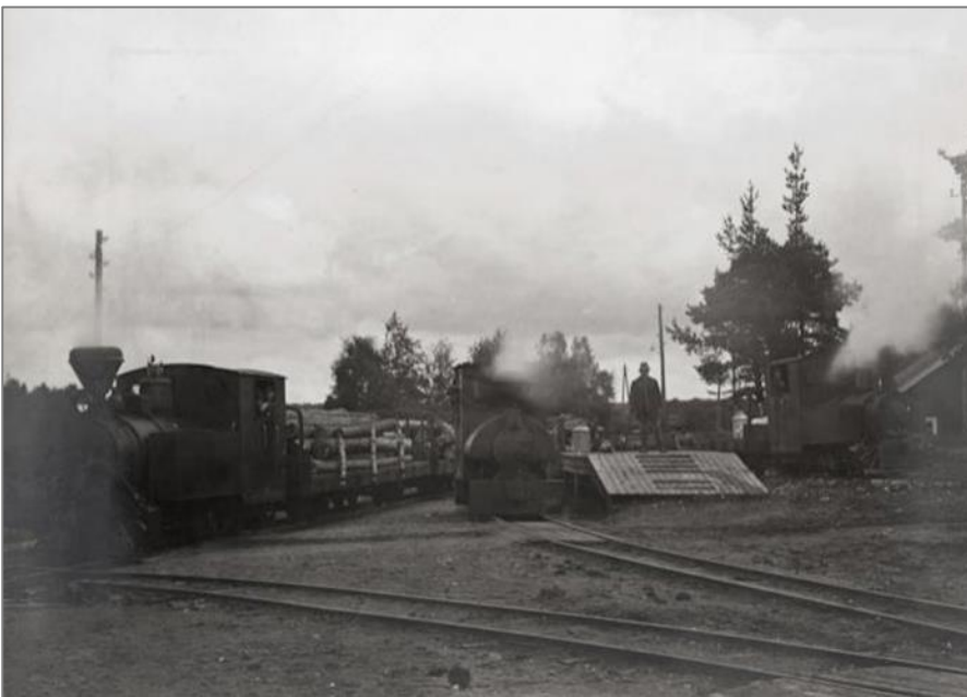
Kuva 6. Ajoittamaton kuva Harvialan kartanon rautatieltä 1900-luvun alusta. Kuvassa on 750 mm raideleveydellä olevia kapearaidehöyryvetureita. Kuva: Lusto – Suomen Metsä museo.
