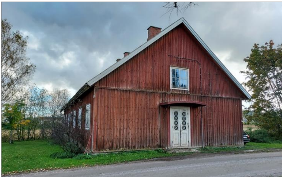
Kuva 54. Lähikuva rakennuksen luoteispäädystä.
