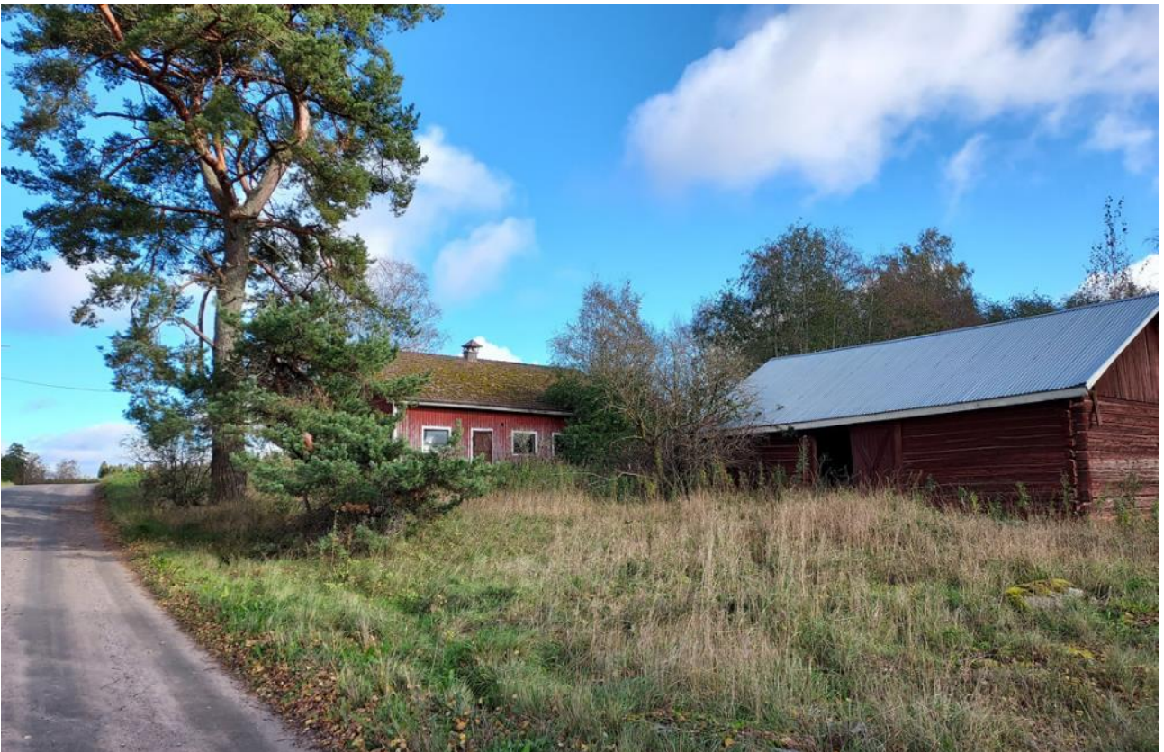
Kuva 73. Alimyllyn talousrakennukset kuvattuna lounaasta.
