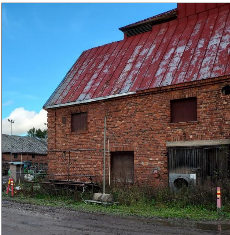
Kuva 55. Lähikuva rakennuksen eteläpäädyistä.
