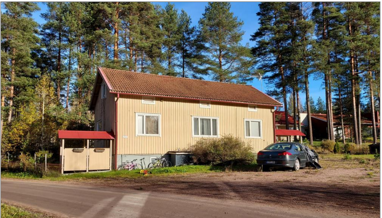
Kuva 97. Entisen nuorisosiirtolan säilynyttä rakennuskantaa.
