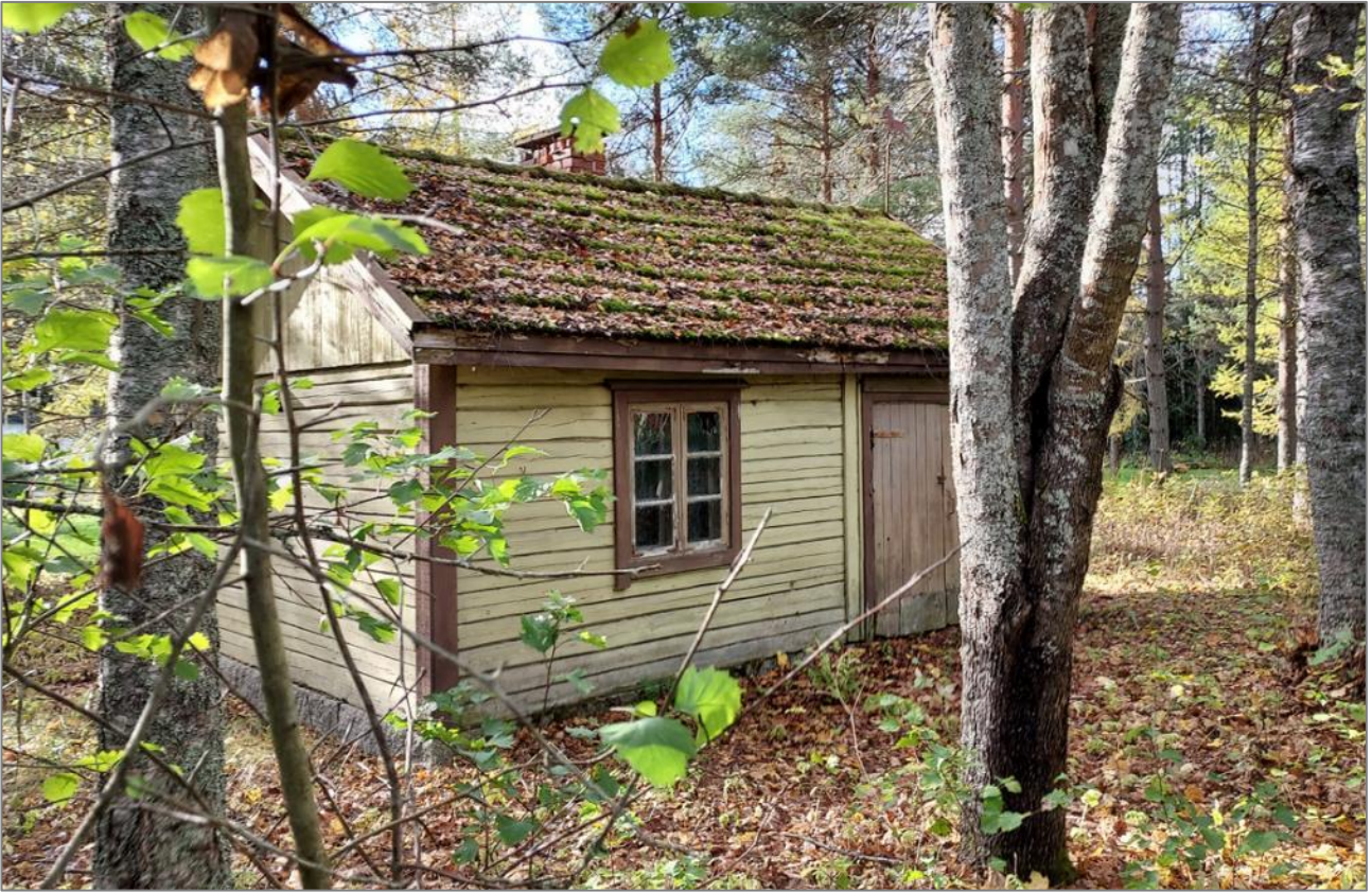
Kuva 94. Rakennuskohde A, Patoniitty-kiinteistöllä sijaitseva hirsirakennus.
