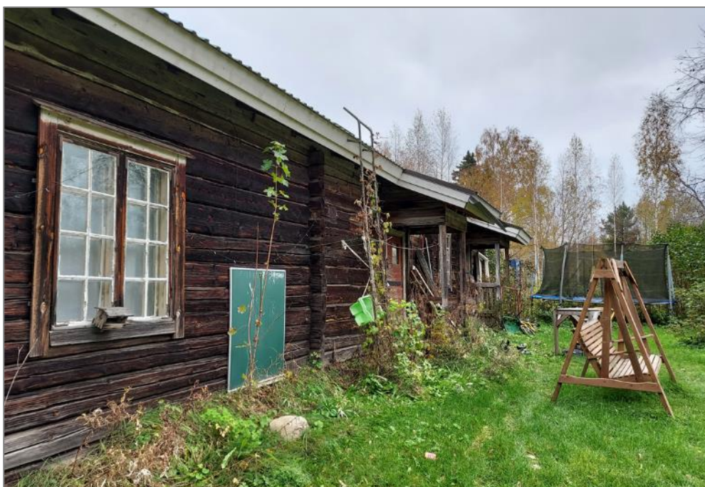
Kuva 114. Rakennuksen lounaissivua kuvattuna pihan puolelta.
