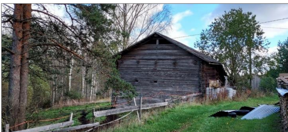
Kuva 86. Joen toisella puolella sijaitseva hirsirakennus.
