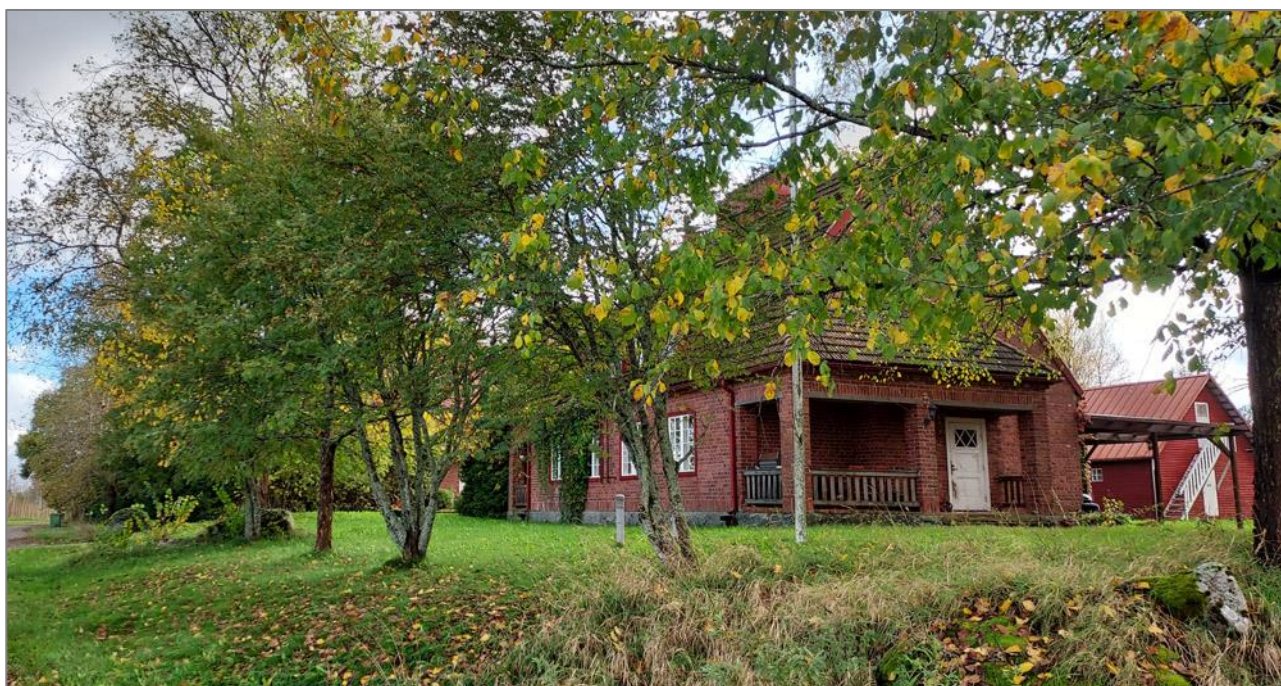
Kuva 60. Katajamäen läntisin asuinrakennus kuvattuna pohjoisesta. Kuvan oikeassa laidassa näkyy 1990-luvulla valmistunut piharakennus.
