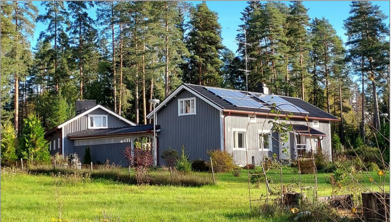
Kuva 98. Entisen nuorisosiirtolan säilynyttä rakennuskantaa.
