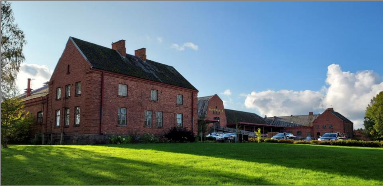
Kuva 49. Karjarakennus kuvattuna idästä.
