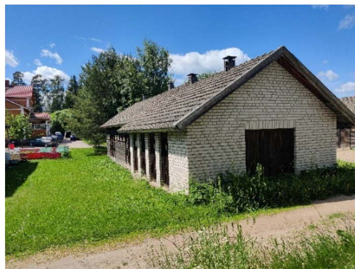
Kuva 29 Varastorakennuksen tiilipäätä Paperintekijäntien varrella.
