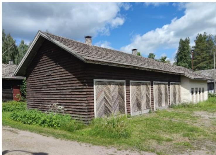
Kuva 28 Varastorakennuksen puujulkisivua Porttilantien varrella.
