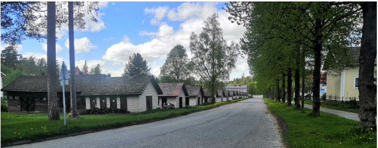
Kuva 31. Paperintekijäntien varrella olevat kuuden perheen tyyppitalojen varistorakennukset.
