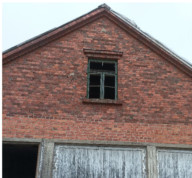
Kuvat 27 ja 28. Rakennuksen tiilirakenteet ovat osin romahtaneet ja saumat halkeilleet. Ikkunalasit ovat rikkoutuneet ja olleet pitkään avoimina.
