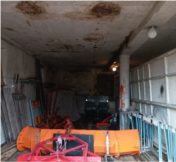
Kuvat 25 ja 26. Tervajoen rannassa oleva tiilirakennus. Rakennuksen sisäkatoissa on laajat vauriot ja katon suojana ollut peite on repeillyt.
