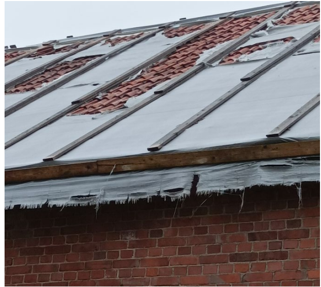
Kuvat 25 ja 26. Tervajoen rannassa oleva tiilirakennus. Rakennuksen sisäkatoissa on laajat vauriot ja katon suojana ollut peite on repeillyt.
