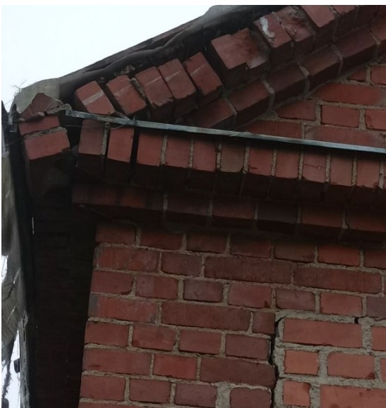
Kuvat 27 ja 28. Rakennuksen tiilirakenteet ovat osin romahtaneet ja saumat halkeilleet. Ikkunalasit ovat rikkoutuneet ja olleet pitkään avoimina.
