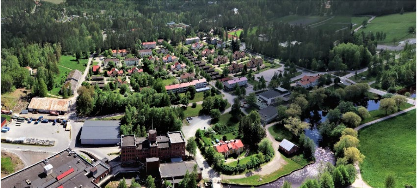
Kaavamuutosaluetta ylhäältä pohjoisesta päin kuvattuna.
