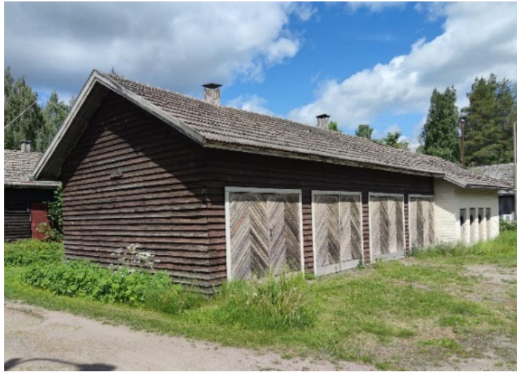
Kuva 28 Varistorakennuksen puujulkisivua Porttilantien varrella.
