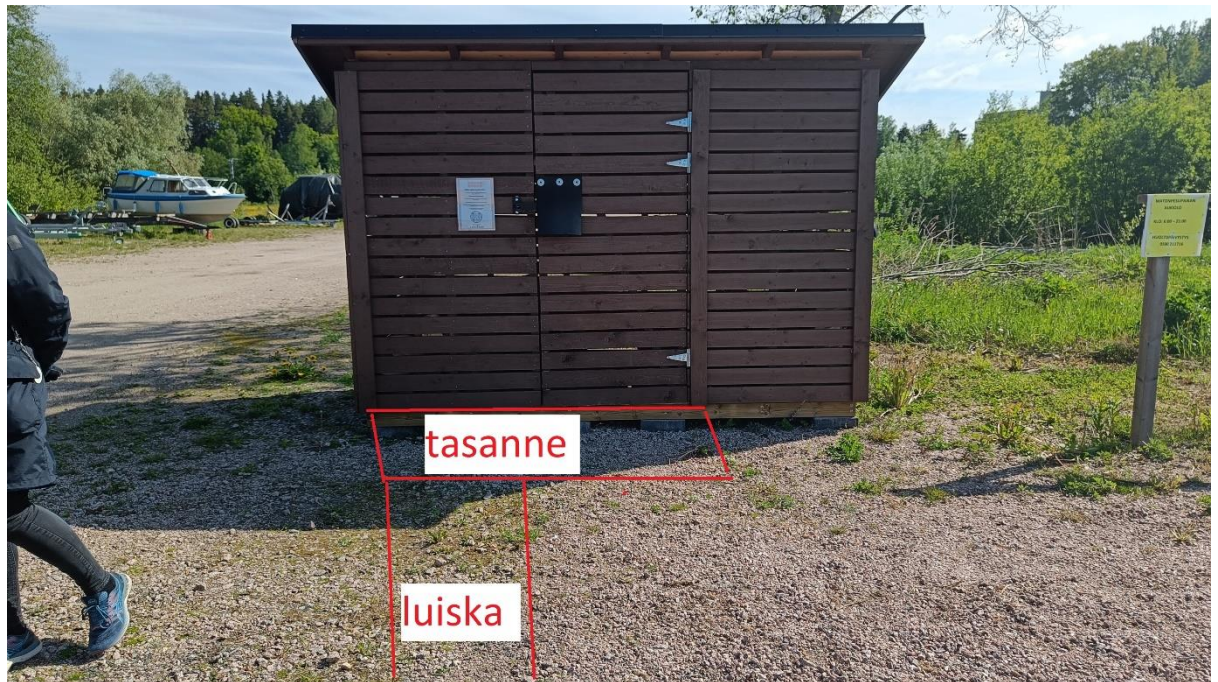
Kuva 7 Lisättävän luiskan ja tasanteen viitteelliset sijainnit
