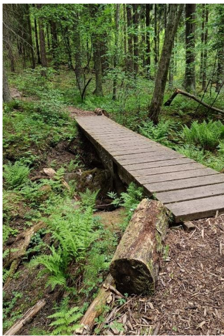
Kuva 21 Reitin silloille lisätään kaiteet ja suojareunukset
