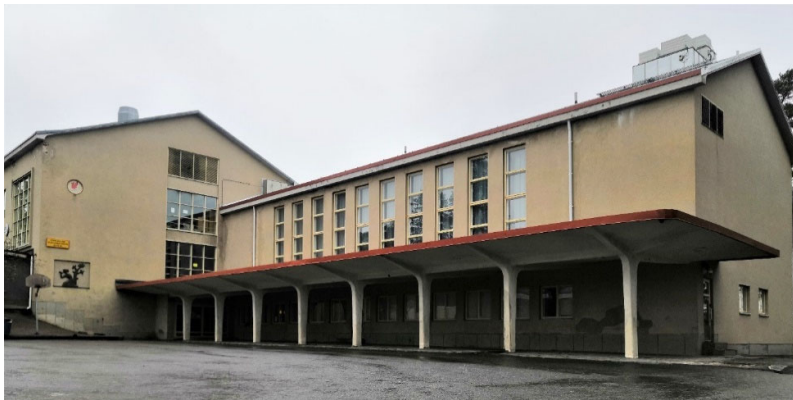
Kuva 10. Kettukallion laella sijaitseva koulurakennus.
