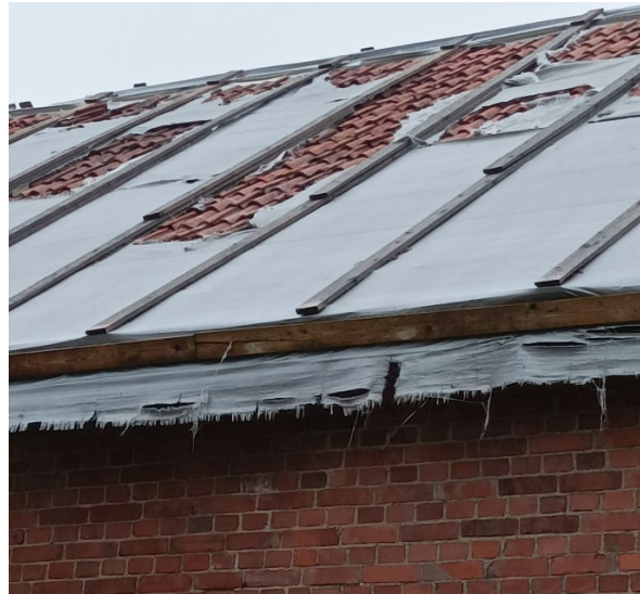
Kuvat 22 ja 23. Tervajoen rannassa oleva tiilirakennus. Rakennuksen sisäkatoissa on laajat vauriot ja katon suojana ollut peite on repeillyt.
