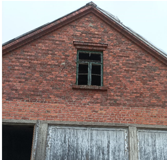
Kuvat 24 ja 25. Rakennuksen tiilirakenteet ovat osin romahtaneet ja saumat halkeilleet. Ikkunalasit ovat rikkoutuneet ja olleet pitkään avoimina.
