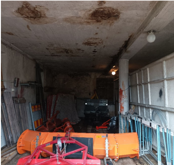
Kuvat 22 ja 23. Tervajoen rannassa oleva tiilirakennus. Rakennuksen sisäkatoissa on laajat vauriot ja katon suojana ollut peite on repeillyt.
