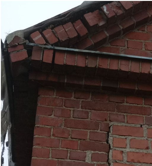
Kuvat 24 ja 25. Rakennuksen tiilirakenteet ovat osin romahtaneet ja saumat halkeilleet. Ikkunalasit ovat rikkoutuneet ja olleet pitkään avoimina.
