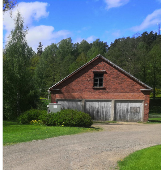
Kuvat 21. Jokirannan tiilirakennus.
