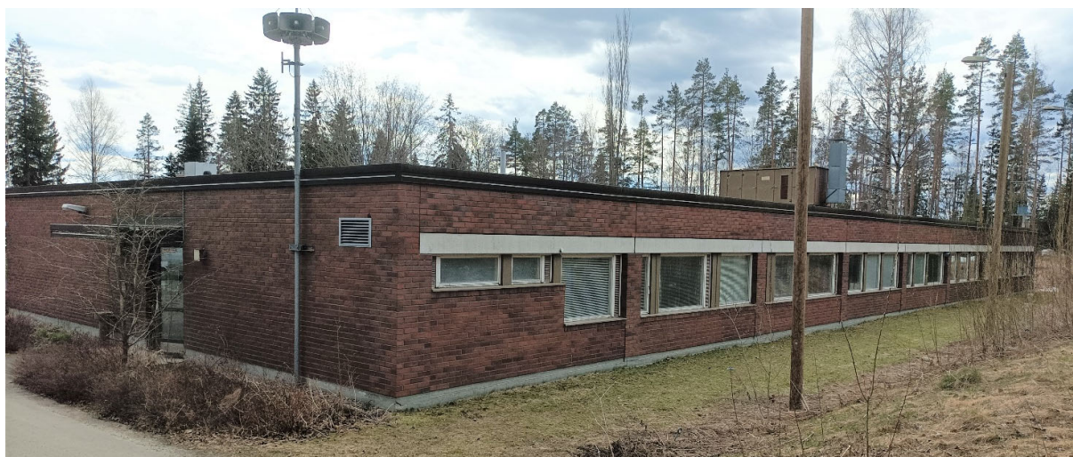
Kuva 18. A-rakennuksen pohjoisempi julkisivu.
