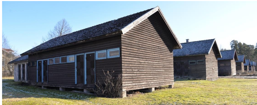
Varastot Kissanhännäntien varressa Porttilantien päädyssä on osin muutettu autotalleiksi. Alakuvassa Paperintekijäntien varrella varastojen puurakenteiset osat on perustettu harkkoille.
