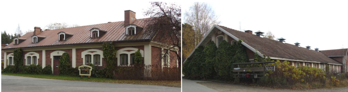
Kuvat 14-15. Autotallirakennus ja yläpakkaamo.
