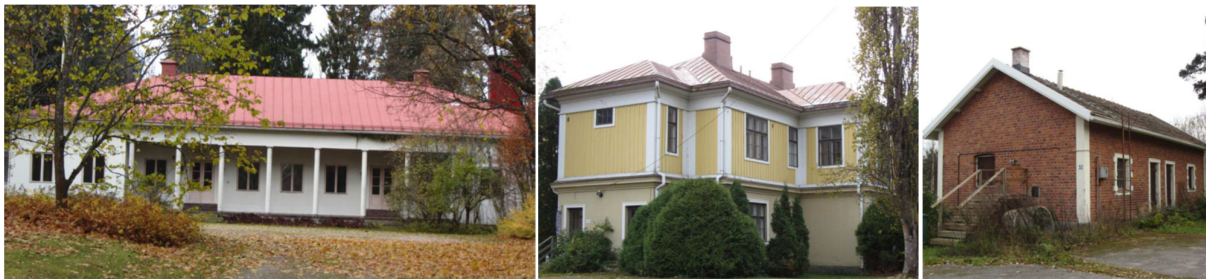
Kuvat 11-13. Kartanon päärakennus, konttorirakennus ja konttorirakennuksen lämpökeskusrakennus.
