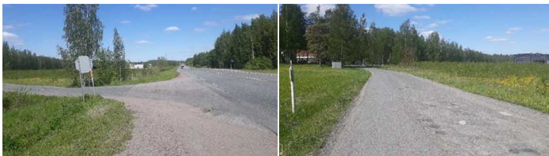
Kuvat 10 ja 11. Ongelmallinen liittymä kuvattuna maantieltä 130 etelän suunnasta ja tiepätkä Koivusillantietä kohti.
