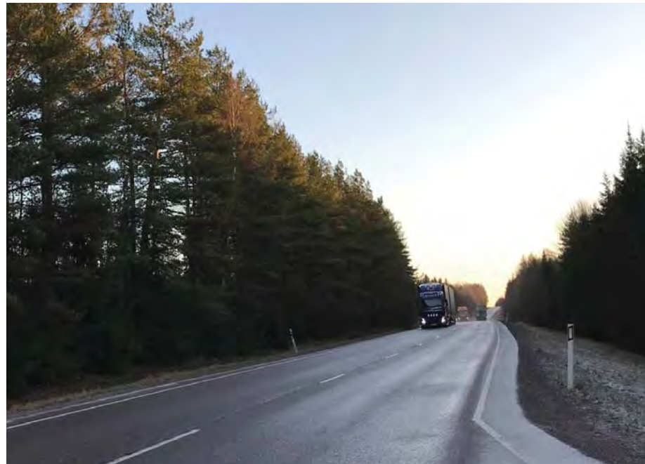
Kuva 2.23. Kantatiellä kulkee paljon raskasta liikennettä.
