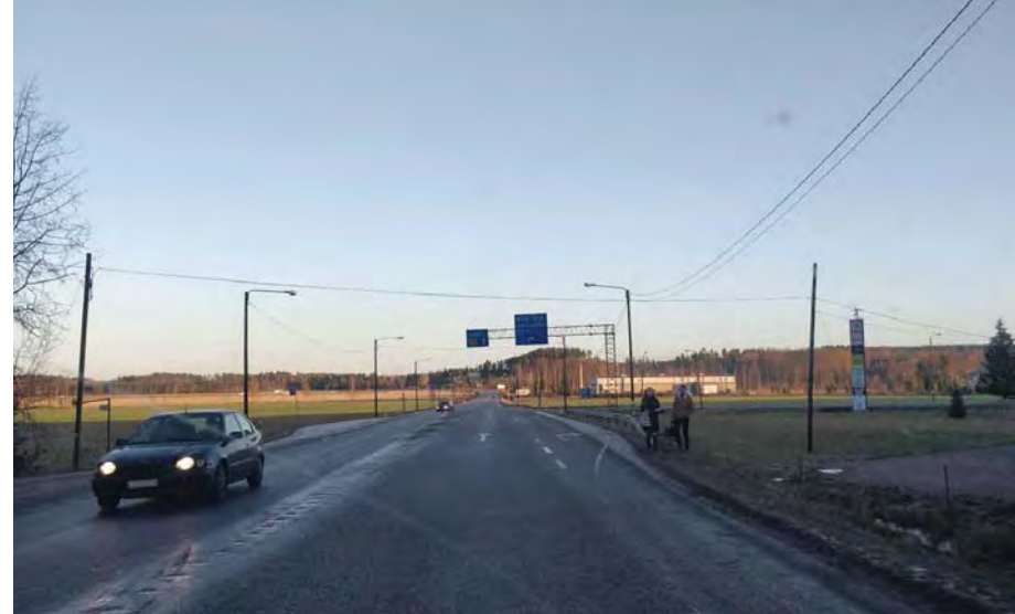
Kuva 2.26. Kantatiellä 54 on useita linja-autopysäkkipareja. Kaikille pysäkeille ei ole kävelyn ja pyöräilyn erita-sojärjestelyä, vaan pysäkeille pääsee ainoastaan ylittämällä kantatien. Kuva Oitin liittymän kohdalta Hausjärvellä.
