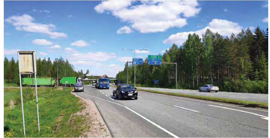
Kuva 3.6. Kantatien 54 ja maantien 130 liittymä on yksirampainen eritasoliittymä. Rampin liikenne jonoutuu vilkkaimman liikenteen aikaan jo nykytilanteessa.
