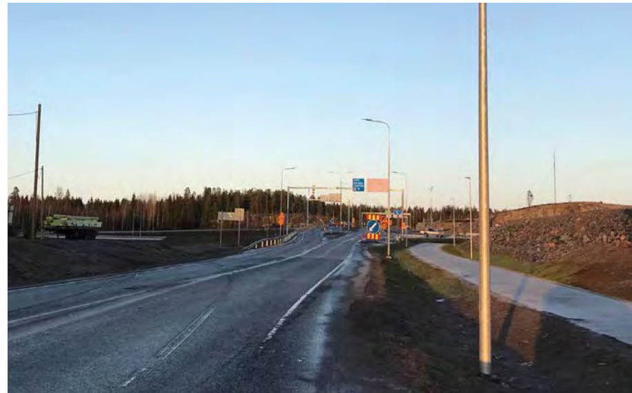
Kuva 1.2. Soramäen eritasoliittymä Hollolassa on rakenteilla. Lahden eteläinen kehätie (vt 12) avataan liikenteelle vuoden 2020 lopulla.
