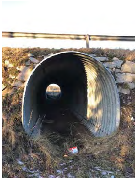
Kuva 2.25. Osa kantatien alikulkukäytävistä on kapeita ja matalia teräsputkisilloja, jotka eivät yhdisty jalankulku- ja pyöräilyverkkoon.
