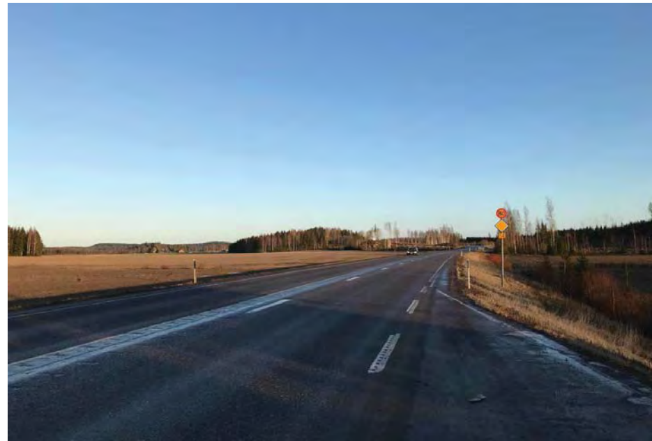
Kuva 4.2. Haapahuhdan ja Oitin välille esitetään leveän keskimerkinnän toteuttamista, sillä sen vaikutuksista on hyviä kokemuksia. Kantatiellä on nykyisin leveää keskimerkintää Oitista itään päin. Kuva Kärkölästä.
