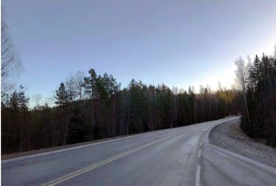
Kuva 2.17. Kantatien suurin vaakageometriapuute on Lopella Kaakkomäen kohdalla, jossa nopeusrajoitus on alennettu (80 km/h) tiegeometrian takia.
