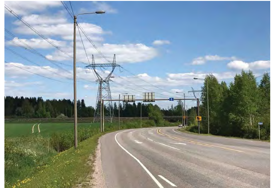
Kuva 4.1. Jalankulku- ja pyöräilyväylän rakentamista esitetään yhteensä noin 30 km matkalle, mm. Riihimäelle Riihiväntien ja Kuulojantien väliselle osuudelle.
