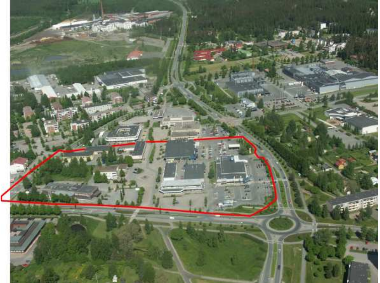
Ilmakuva etelän suunnasta Insinööritoimisto Paavo Ristola Oy 2005
