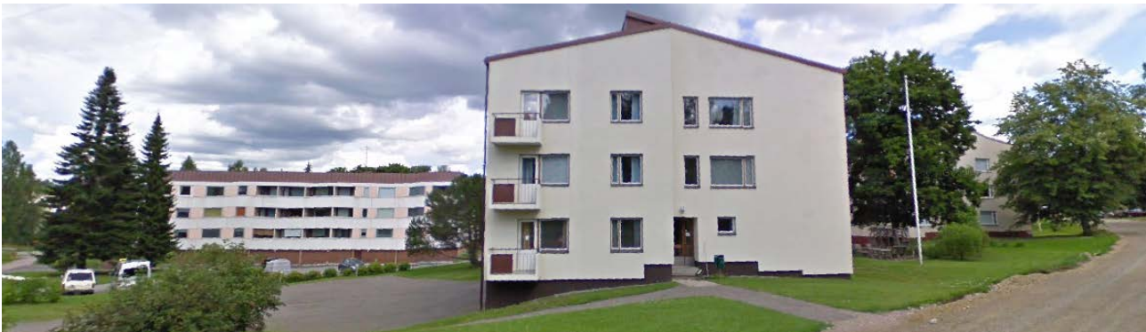
Kuva 13. Alueen eteläosan kerrostalot Juttilantieltä kuvattuna (GoogleMaps).
