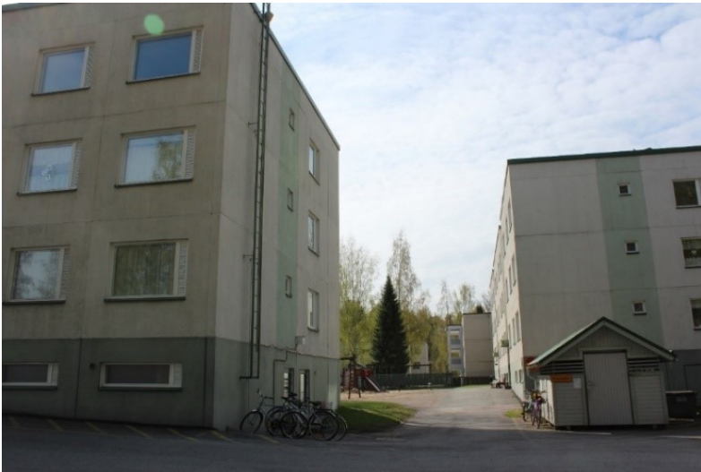
Rakennukset 34. Kolmikerroksiset elementtikerrostalot 1970-luvulta tarjosivat asukkaille nykyaikaiset mukavuudet.
