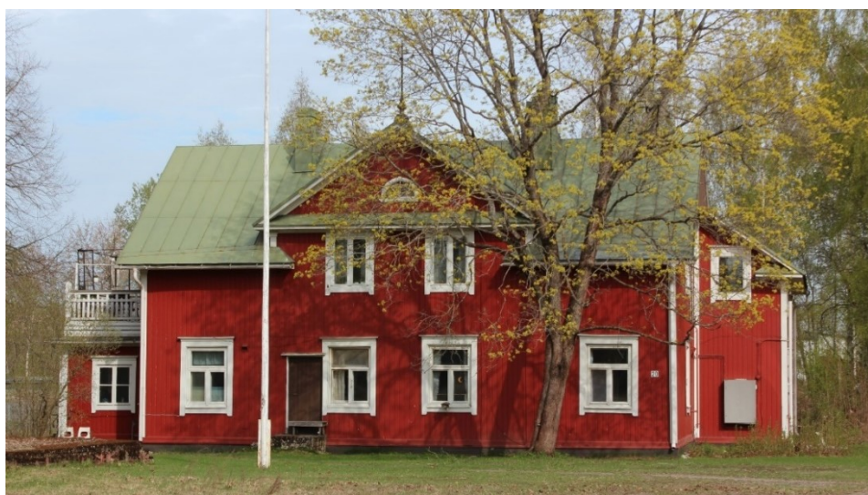
Rakennus 33. Junaradan itäpuolella paikoitusalueen reunalla on 1910-1920-luvun lautaverhoiltu rakennus. Se on sijannut osuuskauppa Sammon takana. Kuvassa vasemmalla näkyy vanhan kaupan liittyneen rakennuksen kivijalkaa.
