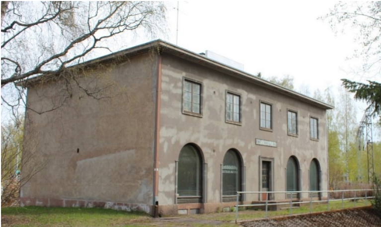
Rakennus 26. Janakkalan osuuskaupan talossa toimii antiikkiliike. Vanha kauppa sijaitsee näkyvällä paikalla junaradan vierellä, mutta sen merkitys katunäkymässä on muuttunut ja sen ohi kulkee vain kevyenliikenteen alikulku.
