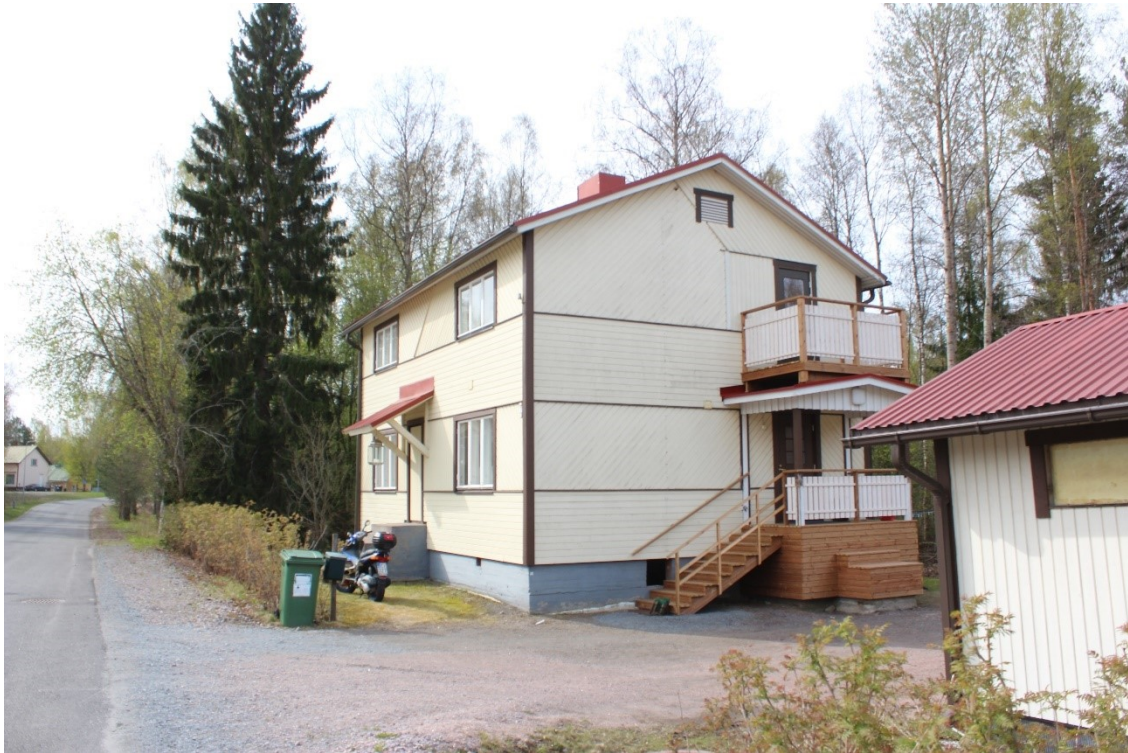
Rakennus 13. Vuonna 1940 rakennetun kaksikerroksisen talon kadunpuoleinen sisäänkäynti on poistettu käytöstä. Portaikko ja parveke on rakennettu myöhemmin ja oikealla näkyvä piharakennus vuonna 1999.
