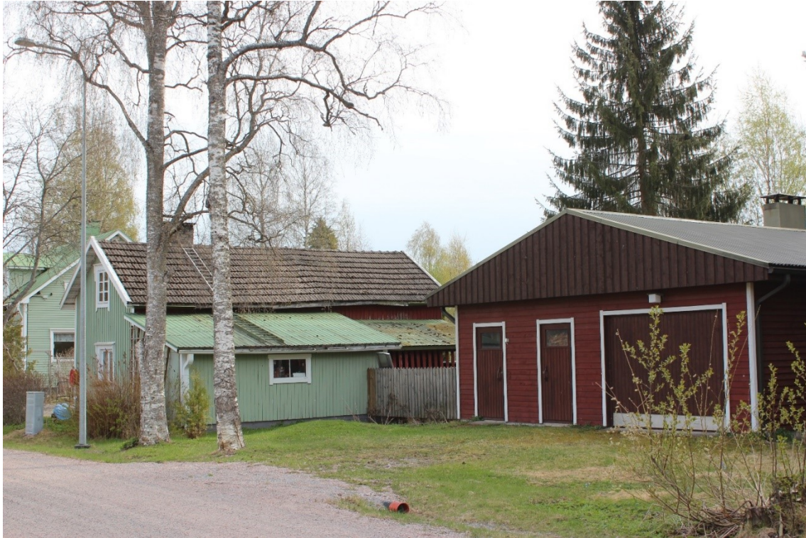
Rakennus 8. (oikealla) ja rakennus 9. (vasemmalla). Lehtotien rakennetusta ympäristöstä poikkeava loivakattoinen autotalli on rakennettu 1981. Taustalla oleva rakennus on 1930-luvulta. Rakennukset sijaitsevat lähellä tietä ja ovat tärkeä osa katunäkymää. 1980-luvun rakennus poikkeaa alueen rakennuskannasta. Myös kaava-alueen ulkopuolelle jäävillä Puistokujalla ja Jokitiellä on 1970- ja 1980-lukujen rakennuksia, jotka eivät ole linjassa alueen yhtenäisen rakentamisen kanssa.
