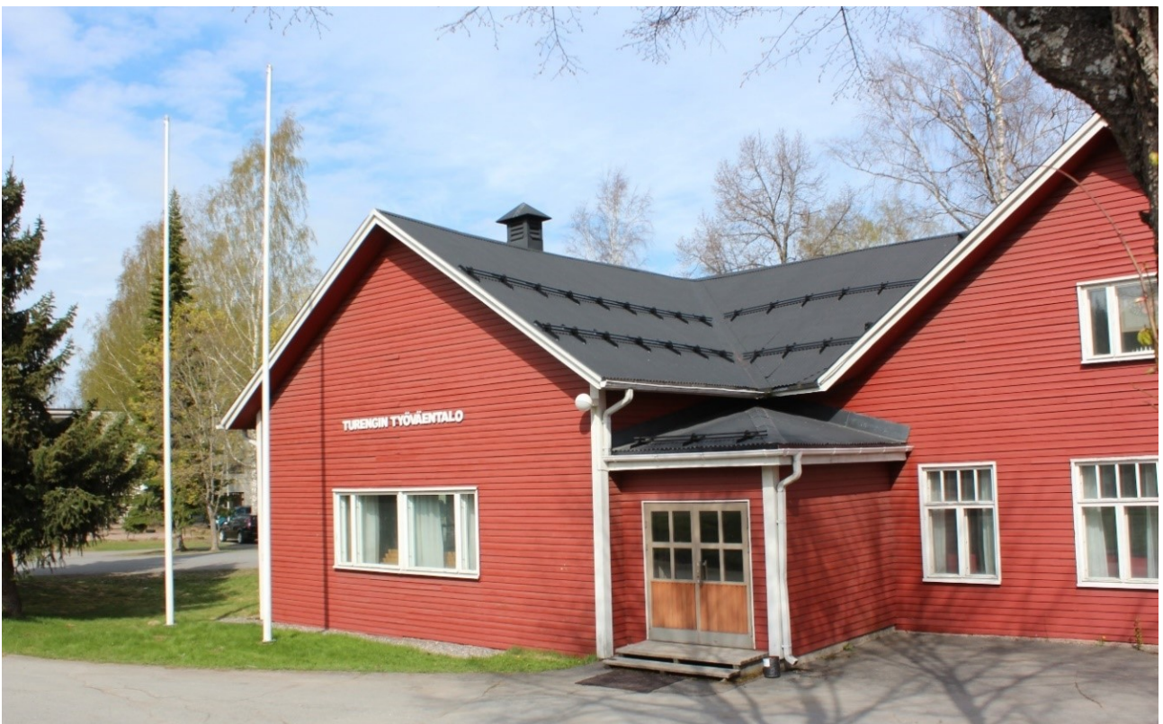
Turengin työväentalo rakennettiin 1910. Se sijaitsee maisemallisesti merkittävällä paikalla Kauppakujan varrella Ojatien risteyksen tuntumassa. Työväentalo jää kaava-alueen rajauksen ulkopuolelle.
