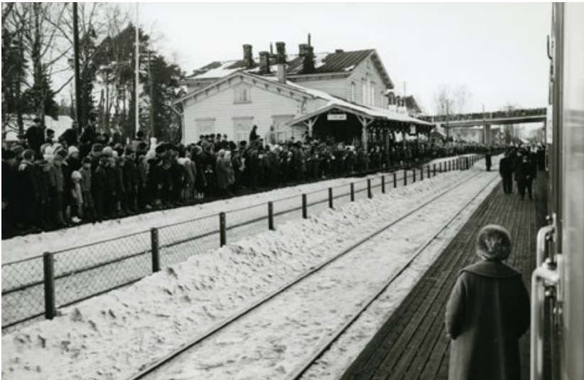
Ihmisiä VR:n 100-vuotisjuhlilla Turengin asemalla 1962. Taustalla näkyy juuri valmistunut Turengintien rautatien ylittävä silta. Suomen rautatiemuseo.
