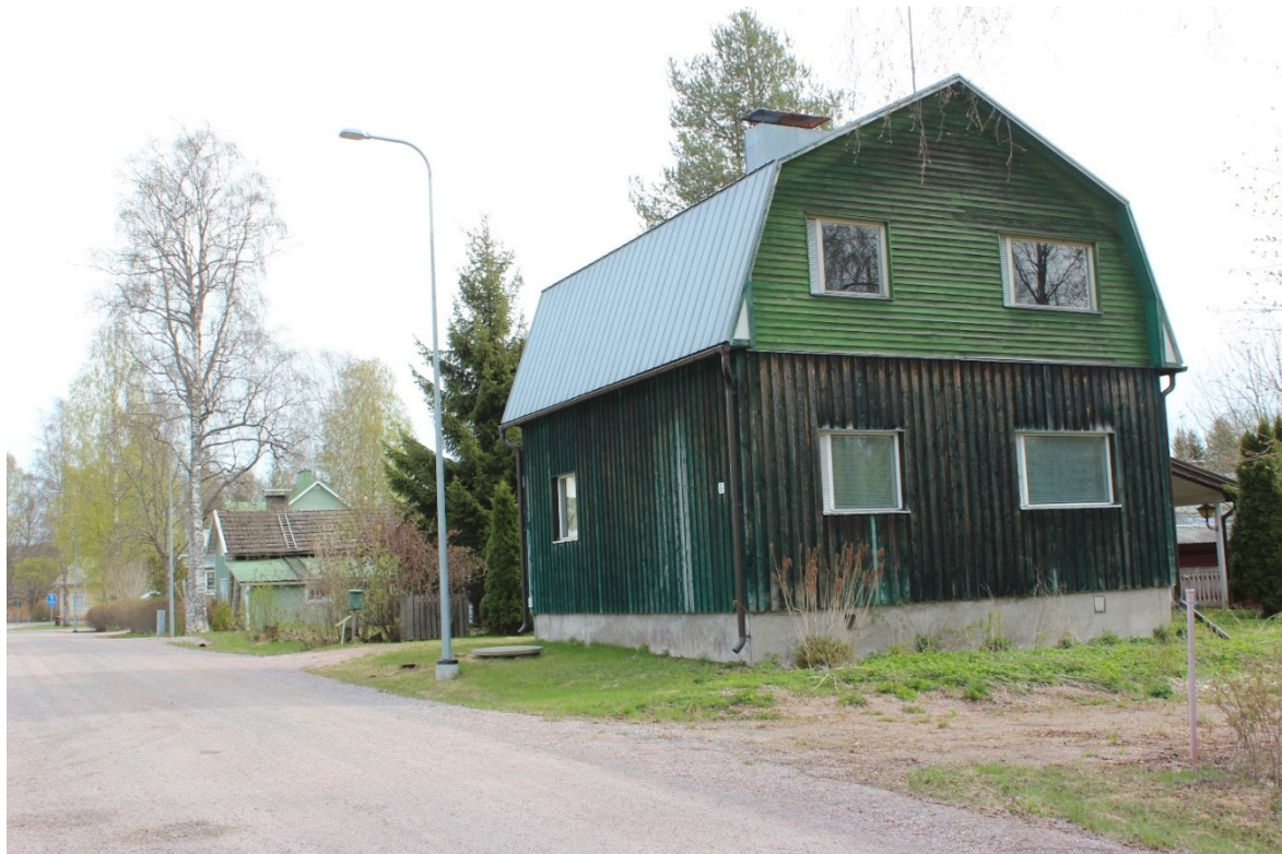
Rakennus 7. Mansardikattoinen vihreä talo on rakennettu 1930. Sen asuinpinta-ala on 70m 2 , mikä on isompi kuin alueen muissa 1920- ja 1930-luvun taloissa. Rakennus on tärkeä osa tien näkymää.
