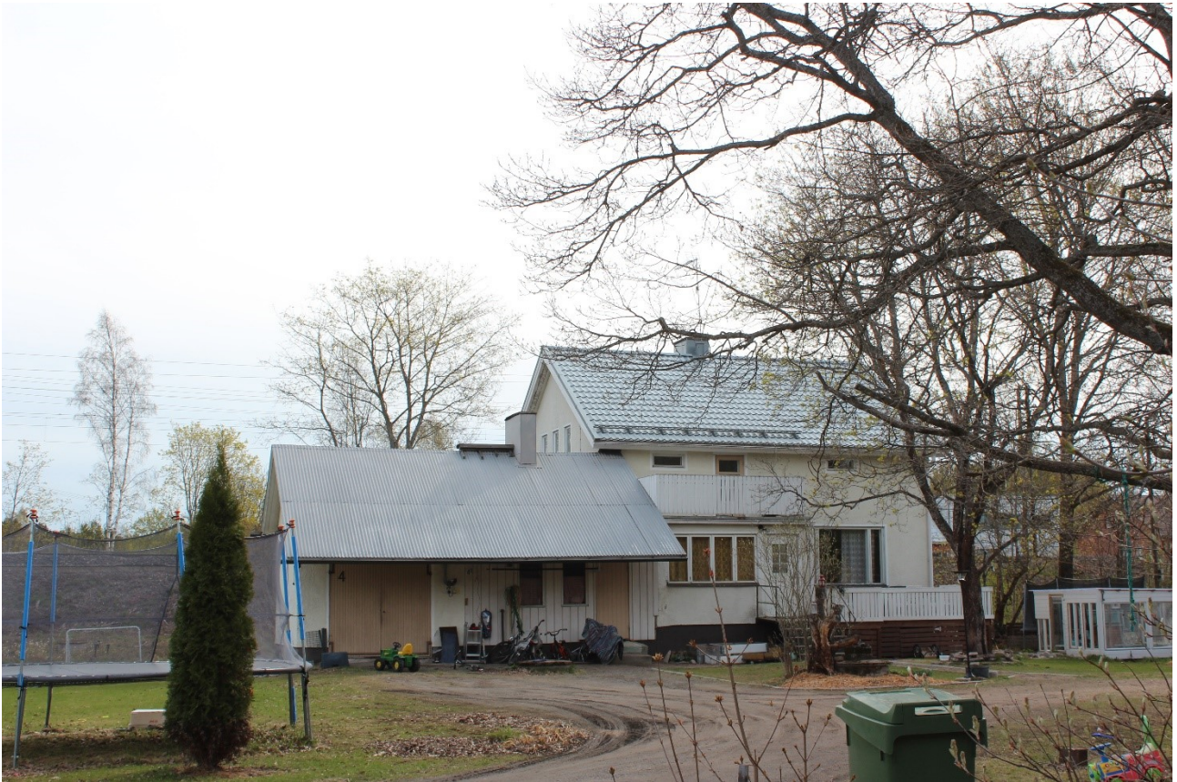
Rakennus 23. Suokujan eteläpuolella on 1952 rakennettu omakotitalo.
