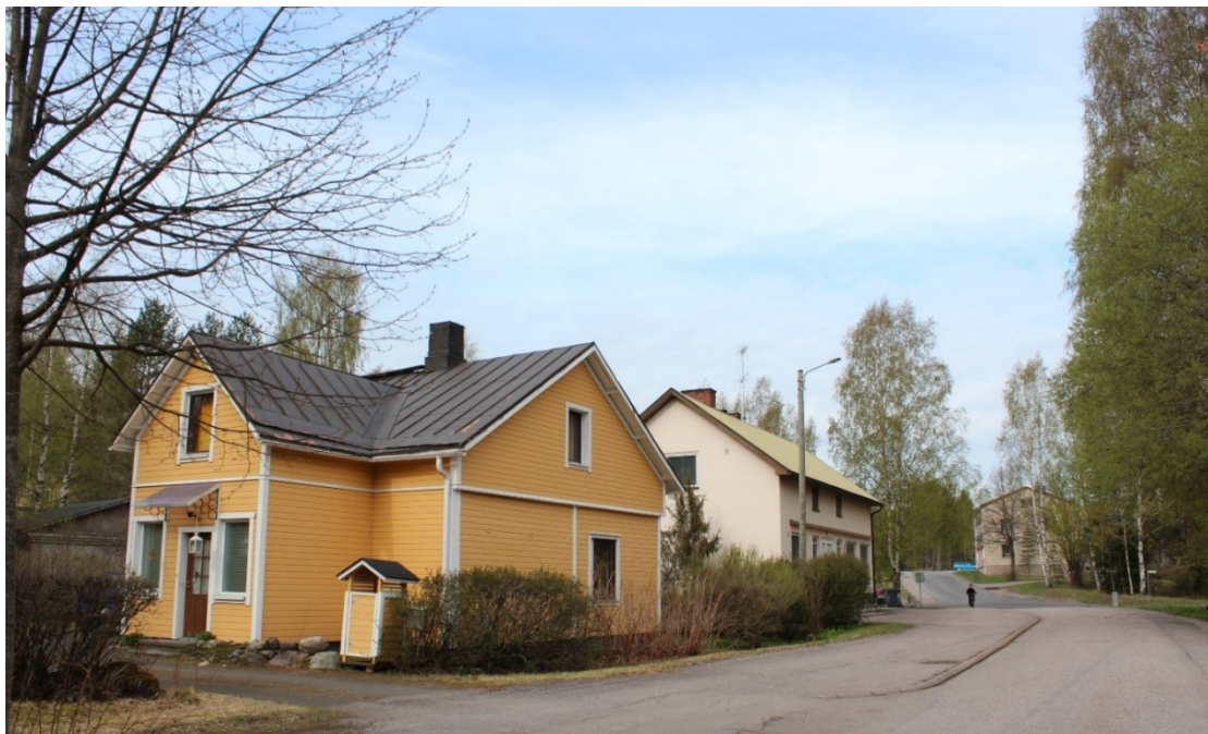
Rakennus 28. Asuinrakennus on rakennettu vuonna 1940. Taustalla liikerakennus vuodelta 1930.
