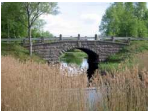
Räikälänjoen kivisilta (TA)
